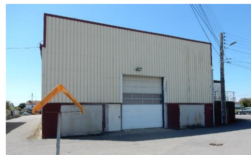
Vue sur les bâtiments de la friche
