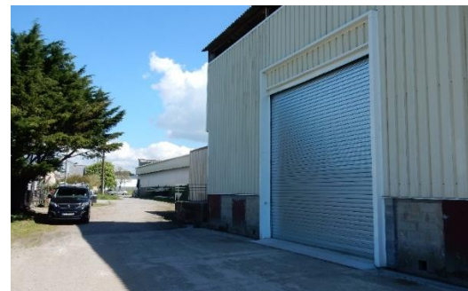
Espace entre le secteur A et le secteur B
