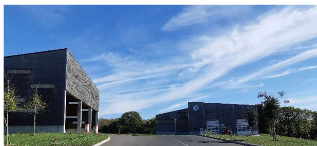
Figure 19 : Installation de transfert de déchets de Villejames à Guérande
