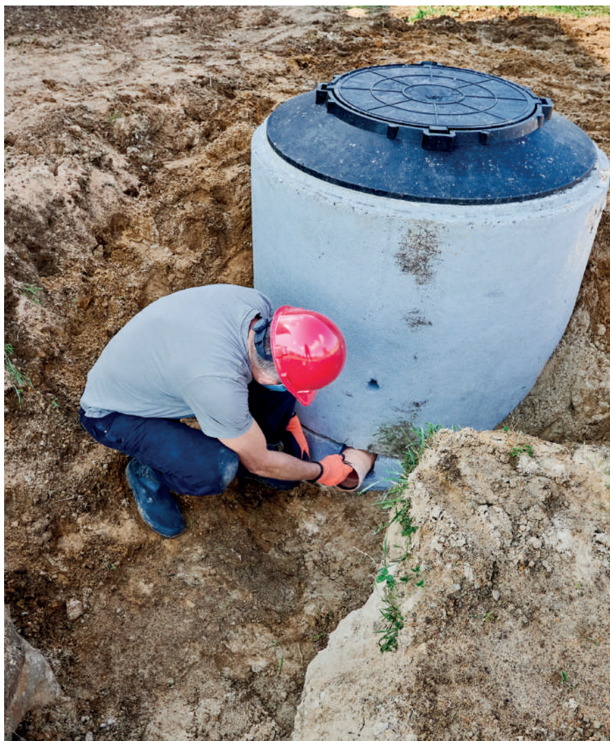
Exemple de mise en place d'une cuve de récupération d'eau enterrée.
