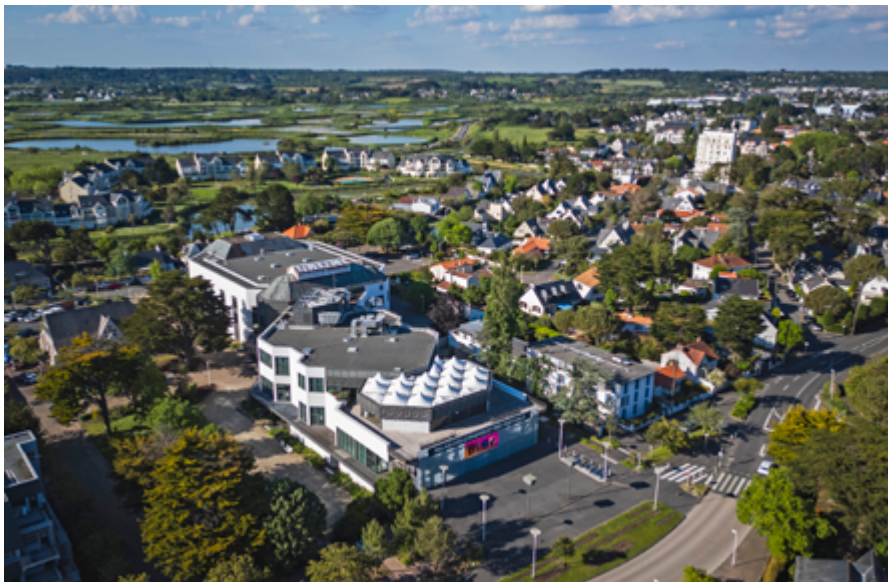
Travaux de fermeture des coursives extérieures d'Atlantia
