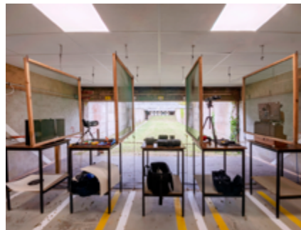
Aménagement de 3 pas de tir pour la Police Municipale
