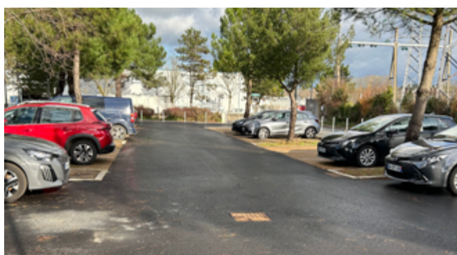
Réfection du parking nord de la gare
