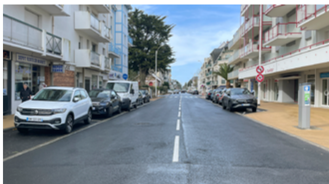
Réfection de l'avenue de Lattre de Tassigny
