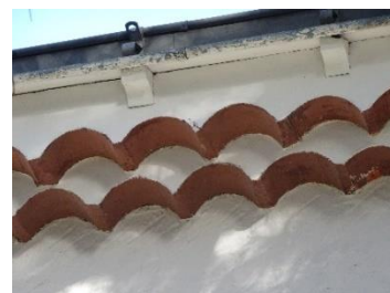
Génoise à deux rangs de tuiles canal
