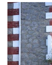
Appareil de granite. Chaîne d'angle en briques ou pierre de taille
