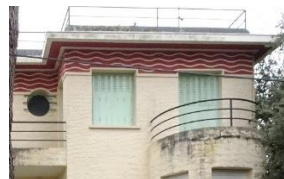
Frise en béton moulé
