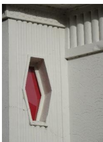
Décor en béton moulé et fenêtre hexagonales
