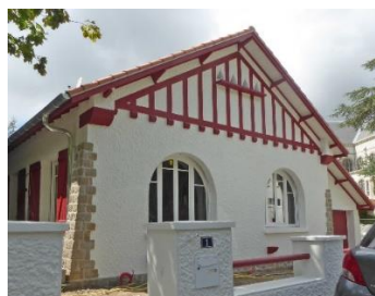
Les extrémités du rez-de-chaussée maçonné présentent un léger fruit ; les petites baies de ventilation (ou autrefois de pigeonier) s'inscrivent entre les bois en comble.
