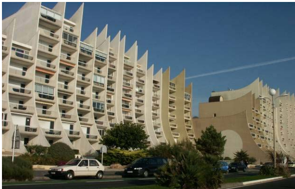
Immeubles « Le Santa Clara » (1979)
