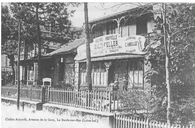
Avenue de la gare
