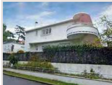
Atlantide, vers 1950, Pierre Bourineau architecte
