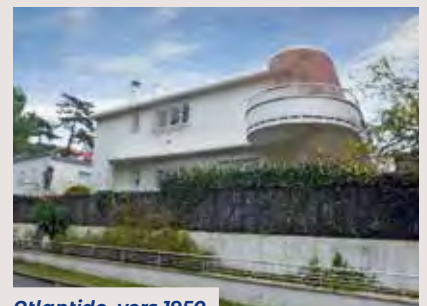
Atlantide, vers 1950, Pierre Bourineau architecte
