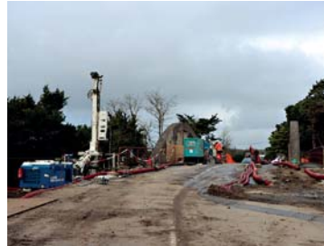
Travaux Pont Chevrel
